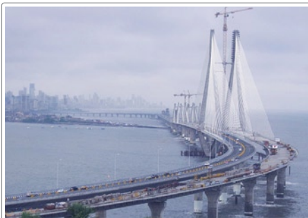
„Mumbai: Mit dem Worli-Bandra-Sea Link ist nach jahrelanger Bauzeit das erste Teilstück der prestigeträchtigen maritimen Umfassungstraße Mumbais eröffnet worden. Die maupflichtige sieben Kilometer lange Seebücke verbindet die Stadtteile Bandra und Worli über die Mahim Bay und verkürzt die Autofahrzeiten von Nord nach Süd-Mumbai um mindestens eine halbe Stunde.“ Bildquelle: Wikipedia, Autor: Jovianeye, Bandra-Worli Sea Link as seen from Taj Lands End, Bandra(W)
